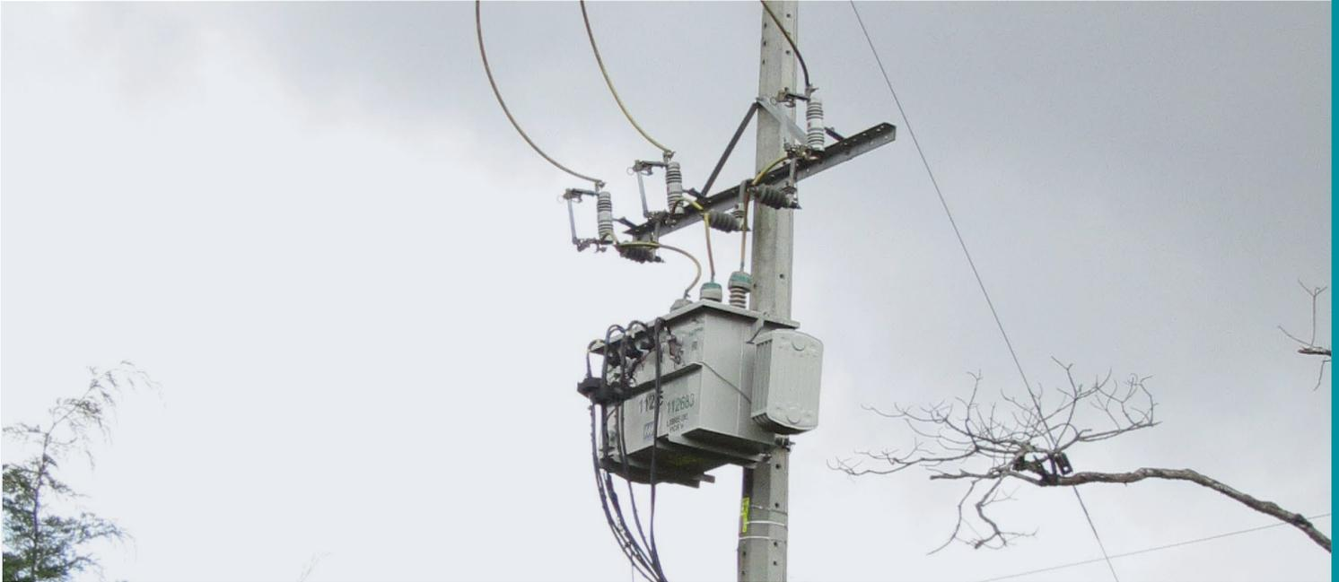
Los seccionadores monopolares abiertos tipo SW en línea fabricados por CELSA son usados para apertura o cierre en aire de sistemas de distribución aéreo por medio de pértiga o para maniobra con carga, mediante accionamiento con herramienta en paralelo LOAD BREAK TOOL.
